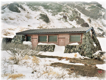
(写真17) 不動平公衆便所東面
