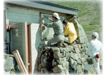
(写真20) 防虫網等補修作業
