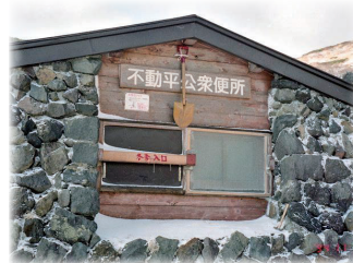
(写真21) 不動平公衆便所の冬期入口
